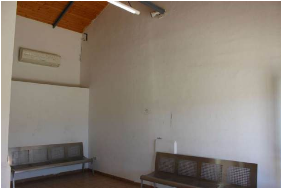
(IMAGEN 53). PAREDES INTERIOR SALA DE ESPERA
